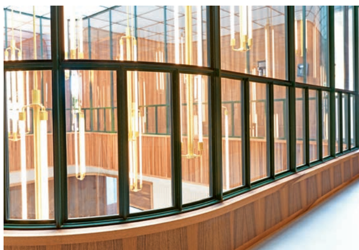
Feinste Profile hochpräzise aneinandergereiht und verschraubt. Profilés très fins alignés et vissés dans la plus grande précision.
