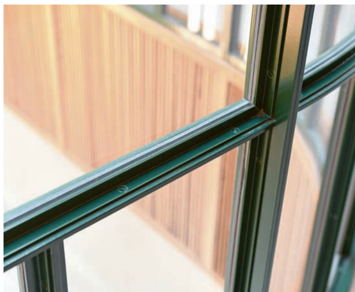
Sämtliche Gläser sind trocken, mit Distanzbändern eingesetzt. Toutes les vitres sont insérées à sec avec des bandes d'écartement.
